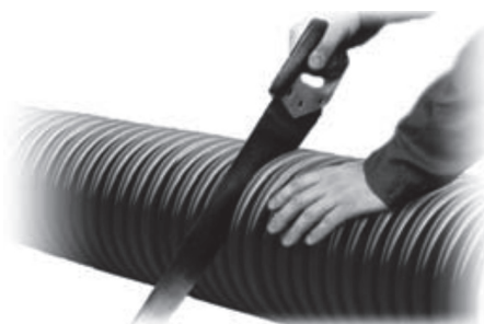
Рисунок 9.20 – Резка ТПСС (стенка из двух слоев – гофрированный наружный и гладкий внутренний слои) плотницкой ножовкой (выкопировка из ТУ 2248-004-50049230-2006 [16])
